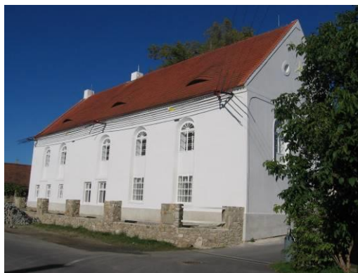
Obrázek 48 Synagoga po rekonstrukci
